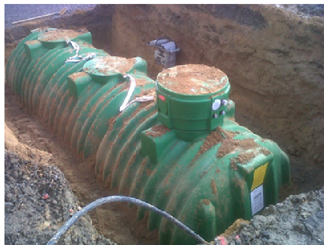
Vue de la cuve
