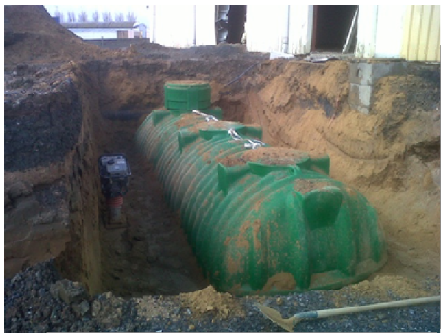
Vue de la cuve
