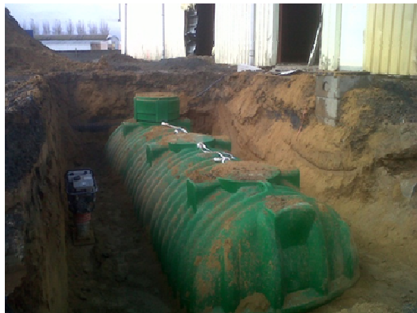
Vue de la cuve
